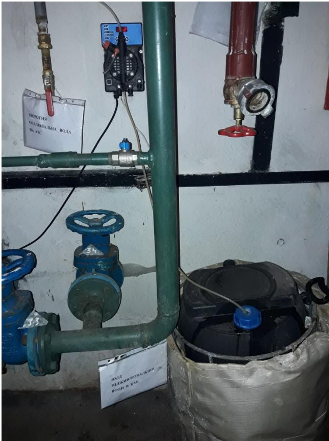
Світлина 1. Насос-дозатор Etatron DLX VFT/MBB 0115, що працює з 2007 року.
