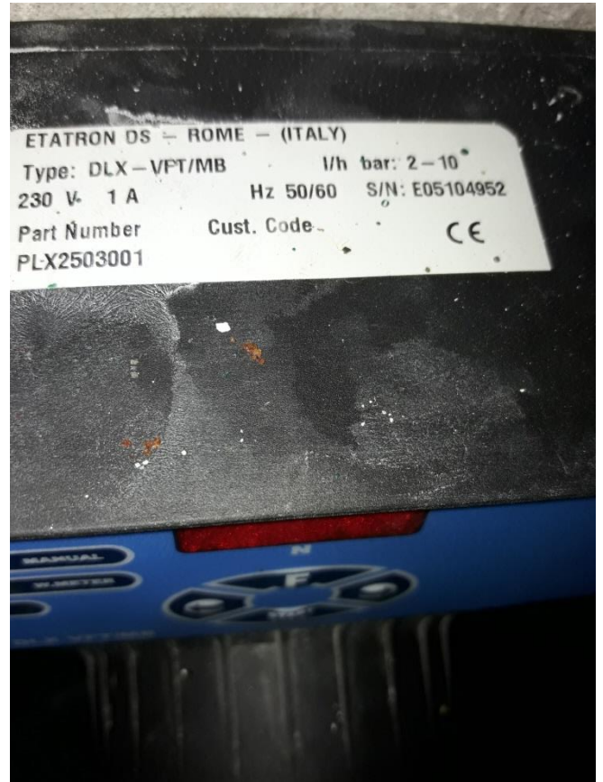
Світлина 1. Насос-дозатор Etatron DLX VFT/MBB 0115, що працює з 2007 року.
