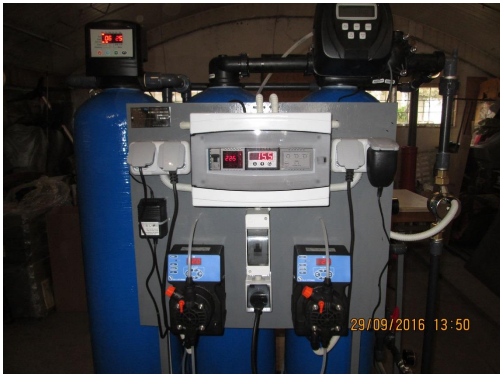
Світлина 2. Насоси дозатори Etataron на комбінованій модульній установці хімічної деаерації та стабілізаційної обробки води КМБУ1.5-М2 виробництва НВО "Нафтохімекологія".
